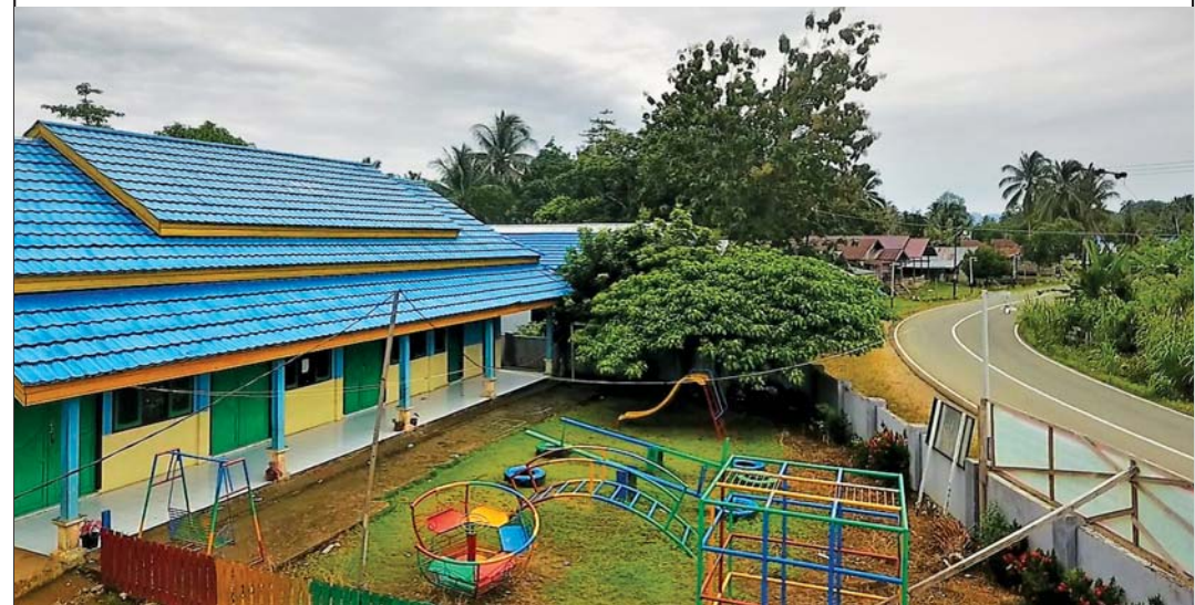
Foto Gedung sekolah TK dan PAUD Kampung Biatan Ilir
